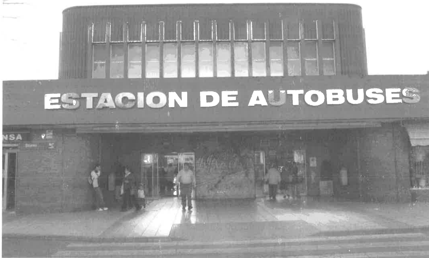
Estación de autobuses, realizada en convenio con el Ministerio. Período 1980-82. La 1.ª que se construyó en la provincia
