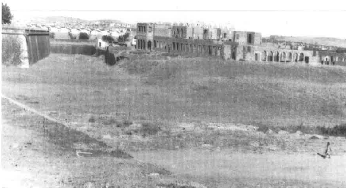
Colegio de la Compañía de María, comienzo de la construcción Avenida de Pardaleras. Años 1951-1952 Fotografía, J. Carlos Vidarte Rebollo
