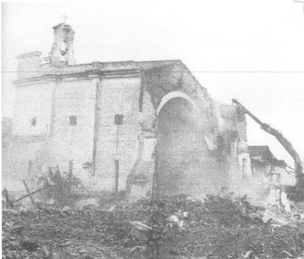
Derribo del viejo edificio que albergó al Asilo de Ancianos en el barrio de Pardaleras. Año 1991. Fotografía Santy
