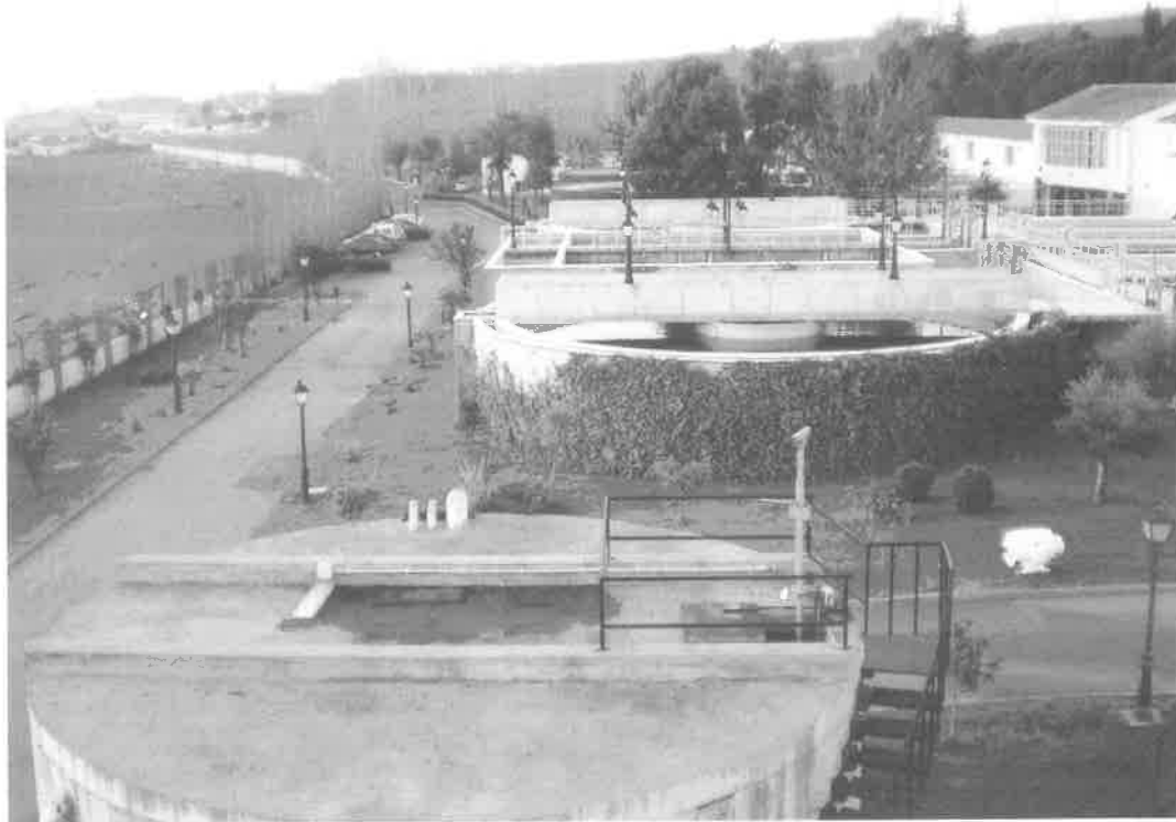
Estación Depuradora ubicada en la Luneta 1980
